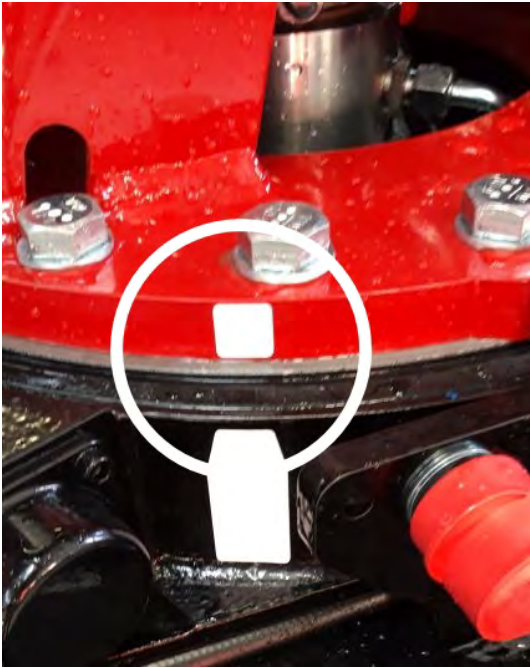
Figur 7.2 Posición central de columna de la grúa
